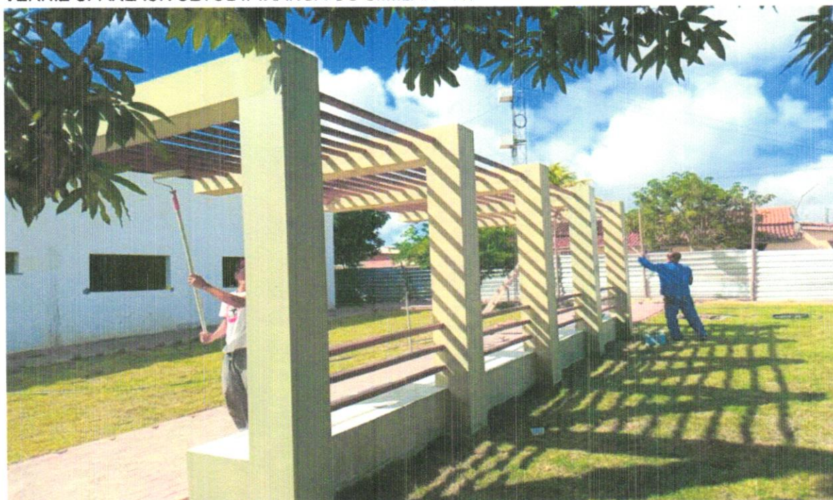
FOTO 42 - PINTURA DE PROTEÇÃO SOBRE MADEIRA COM APLICAÇÃO DE 02 DEMÃOS DE VERNIZ SPARLACK CETOL IPIRANGA OU SIMILAR - R1
