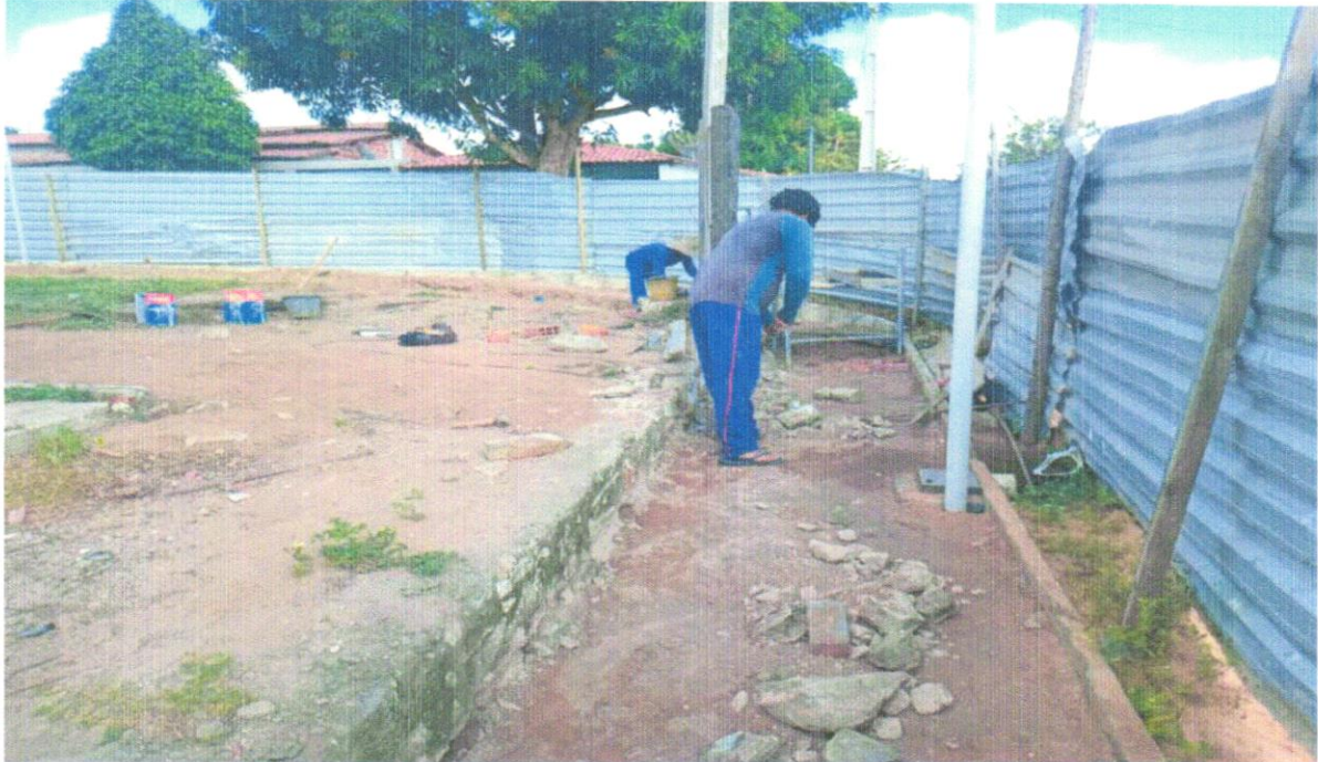
FOTO 02 - DEMOLIÇÃO MANUAL DE PISO CIMENTADO SOBRE LASTRO DE CONCRETO - REV 01
