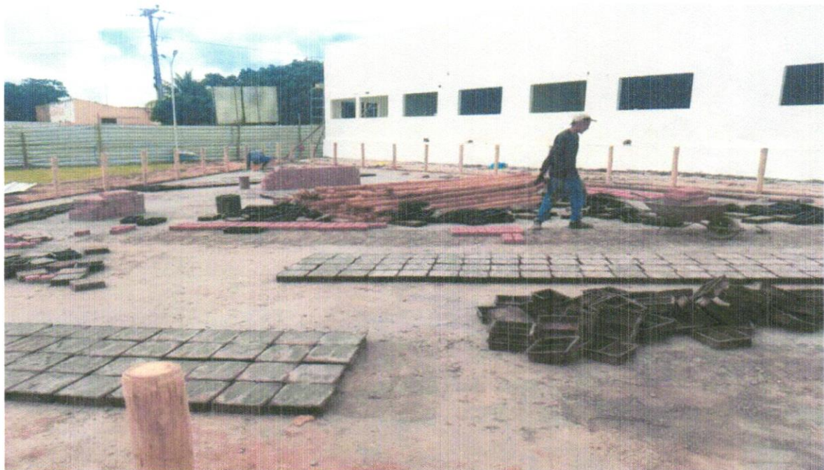
FOTO 66 - FORNECIMENTO E ASSENTAMENTO DE PEÇAS DE EUCALIPTO TRATADO, D=7 A 10CM
