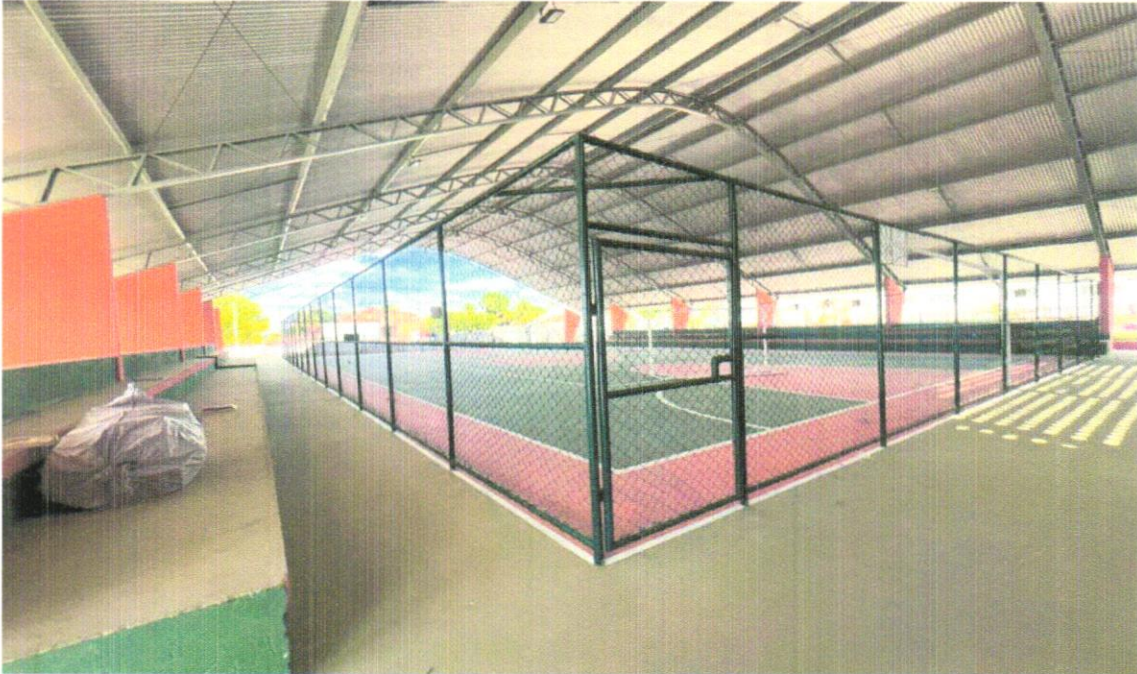
FOTO 84 - PINTURA DE ACABAMENTO COM APLICAÇÃO DE 02 DEMÃOS DE ESMALTE SINTÉTICO SOBRE SUPERFÍCIES METÁLICAS - R1
