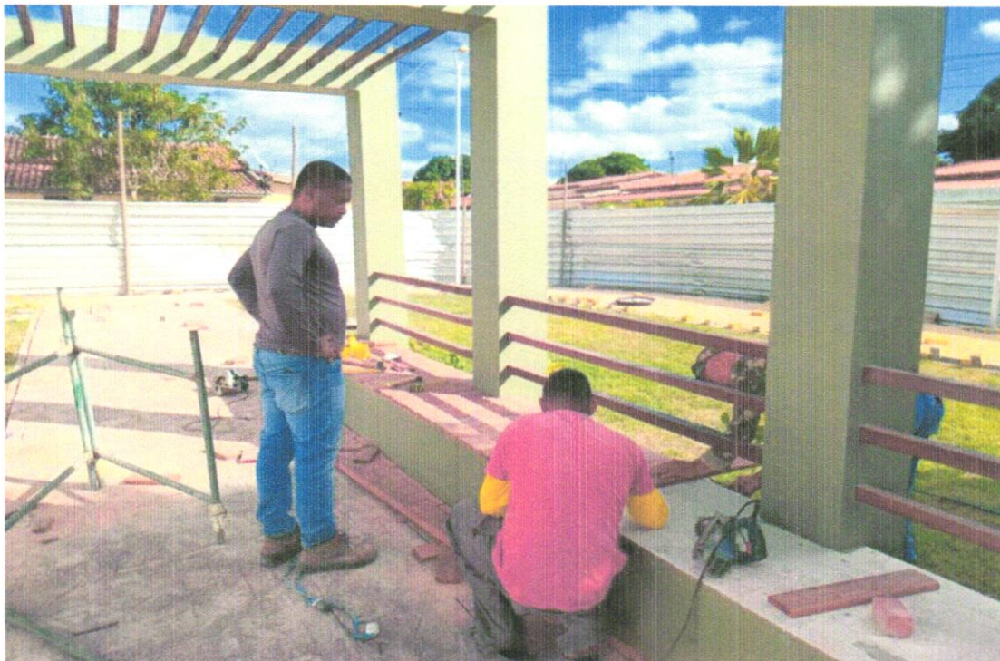
FOTO 90 - MADEIRAMENTO EM MASSARANDUBA/MADEIRA DE LEI, SERRADA 5CM X 5CM
