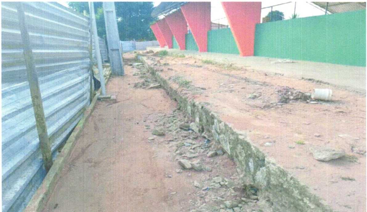
FOTO 02 - DEMOLIÇÃO MANUAL DE PISO CIMENTADO SOBRE LASTRO DE CONCRETO - REV 01
