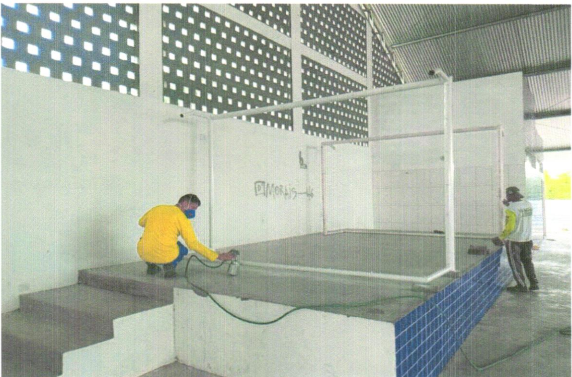
FOTO 84 - PINTURA DE ACABAMENTO COM APLICAÇÃO DE 02 DEMÃOS DE ESMALTE SINTÉTICO SOBRE SUPERFÍCIES METÁLICAS - R1
