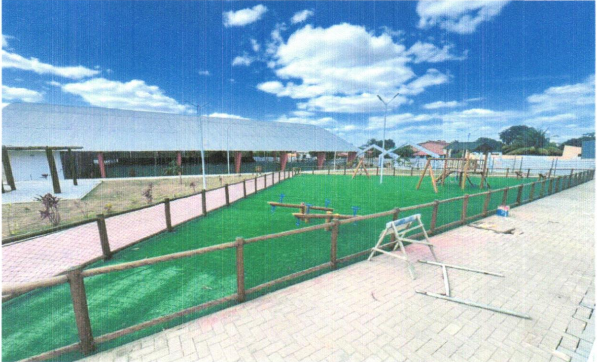
FOTO 70 - FORNECIMENTO E ASSENTAMENTO DE PEÇAS DE EUCALIPTO TRATADO, D=7 A 10CM
