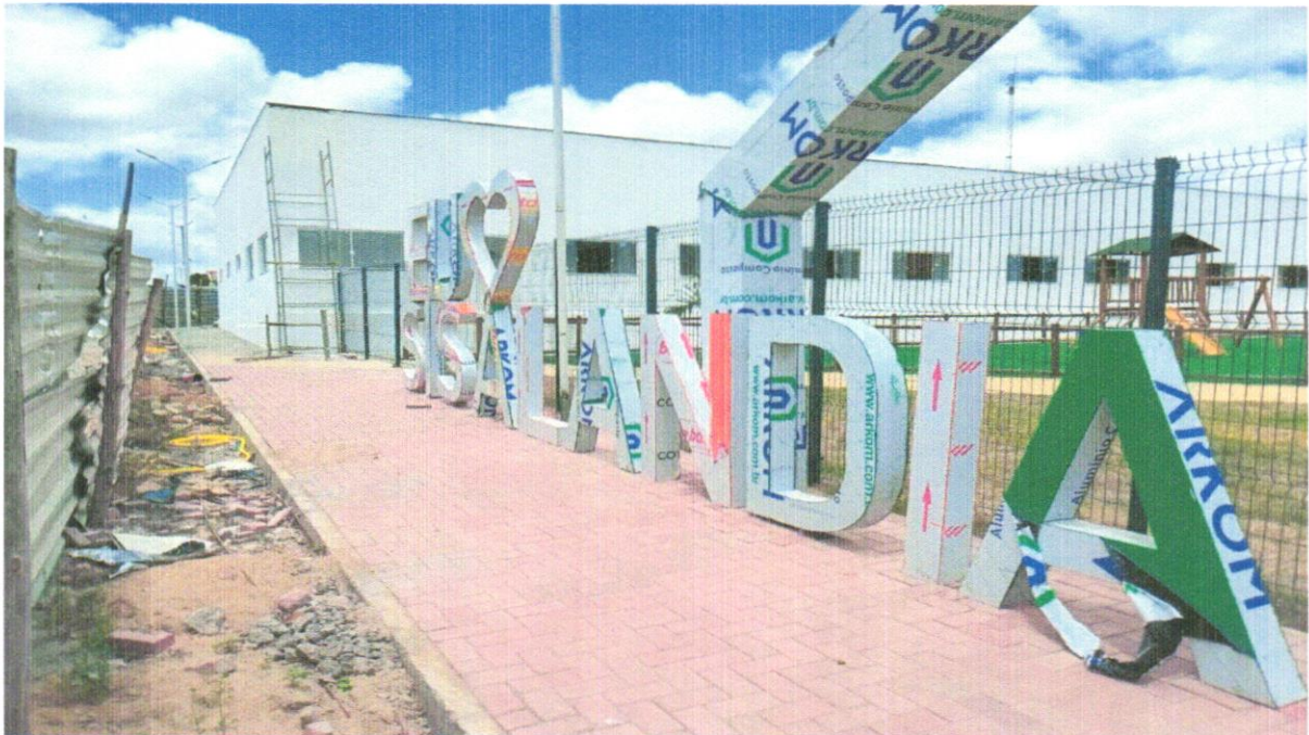
FOTO 92 - Revestimento metálico em alumínio composto (Alucobond), e=0,3mm, pintura Kaynar 500 composta por seis camadas, inclusive estrutura metálica auxiliar em perfil de viga "U" de 2" - fornecimento e montagem
