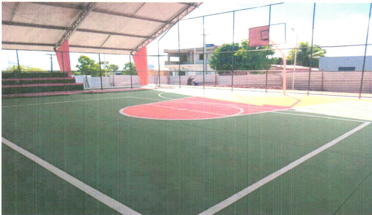
FOTO 82 - PINTURA P/PISO À BASE LATEX ACRÍLICO, TIPO "NOVACOR"
