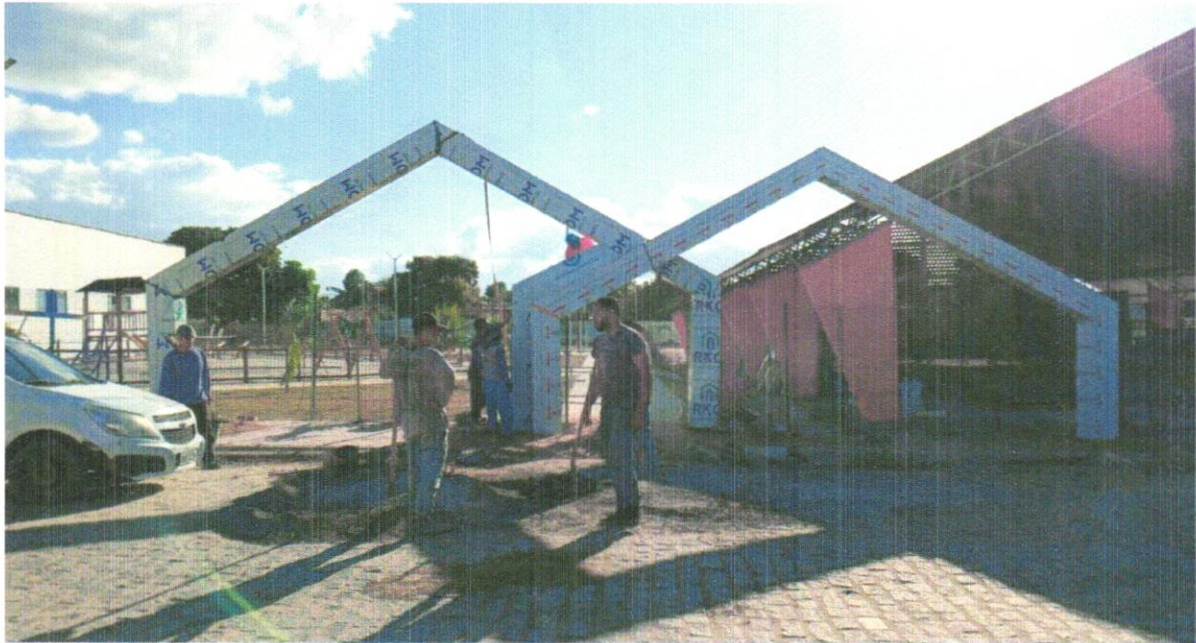
FOTO 92 - Revestimento metálico em alumínio composto (Alucobond), e=0,3mm, pintura Kaynar 500 composta por seis camadas, inclusive estrutura metálica auxiliar em perfil de viga "U" de 2" - fornecimento e montagem
