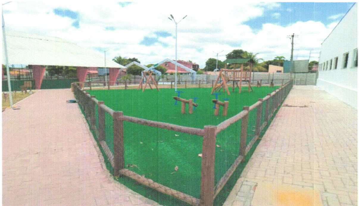
FOTO 70 - FORNECIMENTO E ASSENTAMENTO DE PEÇAS DE EUCALIPTO TRATADO, D=7 A 10CM
