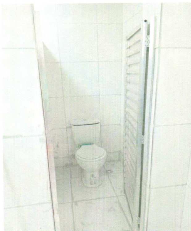
FOTO 44 - VASO SANITÁRIO SIFONADO COM CAIXA ACOPLADA LOUÇA BRANCA - PADRÃO MÉDIO, INCLUSO ENGATE FLEXÍVEL EM METAL CROMADO, 1/2 X 40CM - FORNECIMENTO E INSTALAÇÃO. AF_01/2020
