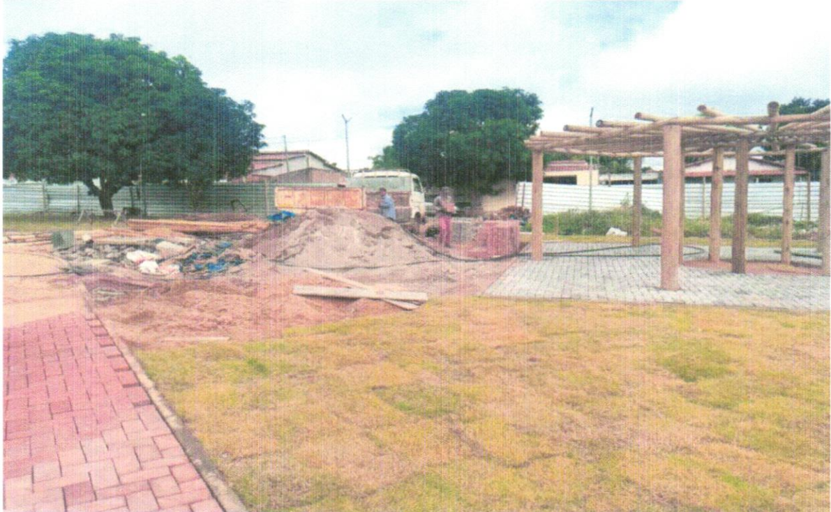
FOTO 66 - FORNECIMENTO E ASSENTAMENTO DE PEÇAS DE EUCALIPTO TRATADO, D=7 A 10CM
