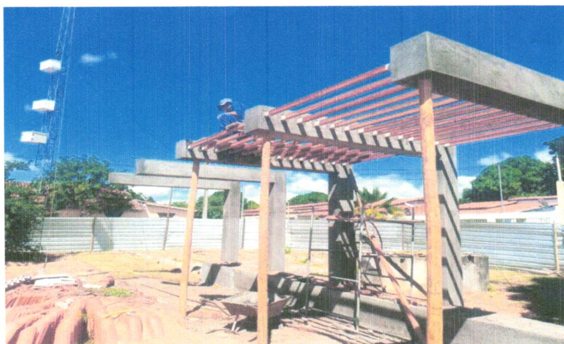
FOTO 60 - MADEIRAMENTO EM MASSARANDUBA/MADEIRA DE LEI, SERRADA 2,5CM X 10CM
