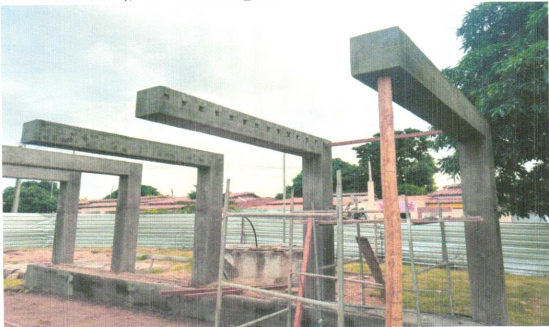
FOTO 58 - (COMPOSIÇÃO REPRESENTATIVA) EXECUÇÃO DE ESTRUTURAS DE CONCRETO ARMADO, PARA EDIFICAÇÃO HABITACIONAL UNIFAMILIAR TÉRREA (CASA EM EMPREENDIMENTOS), FCK = 25 MPA. AF_01/2017
