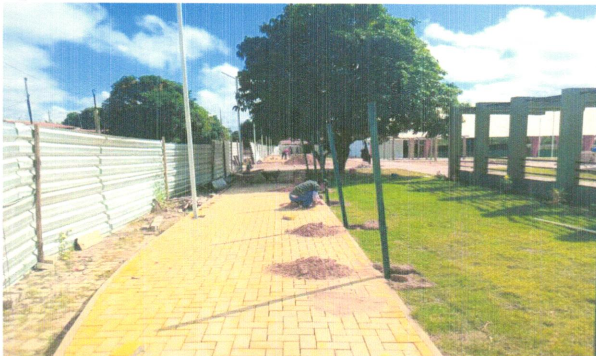
FOTO 34 - EXECUÇÃO DE PAVIMENTO EM PISO INTERTRAVADO, COM BLOCO SEXTAVADO DE 25 X 25 CM, ESPESSURA 6 CM. (LARANJA, AMARELO, GRAFITE, NATURA) AF_12/2015
